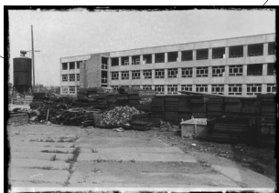
Szkola w budowie
